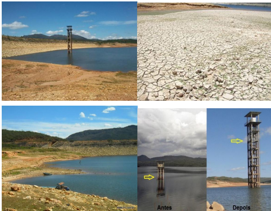
Figura 3–Barragem Luís Vieira- Rio de Contas-BA - volume de água muito abaixo do limite
