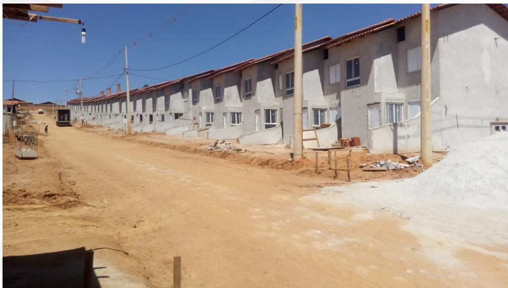
Figura 01: Loteamento PMCMV na cidade de Caetité-Bahia em fase de acabamento.
