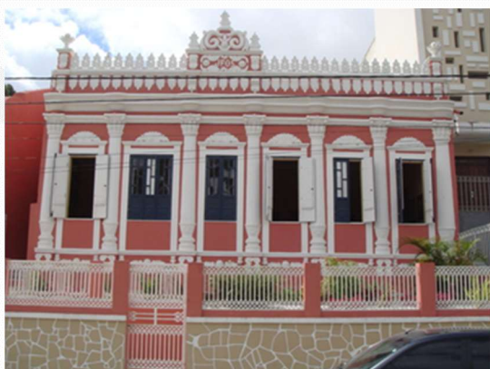
FIGURA 01: Fachada Atual da Casa Regis Pacheco FONTE: Resenha Geral, 2011.
