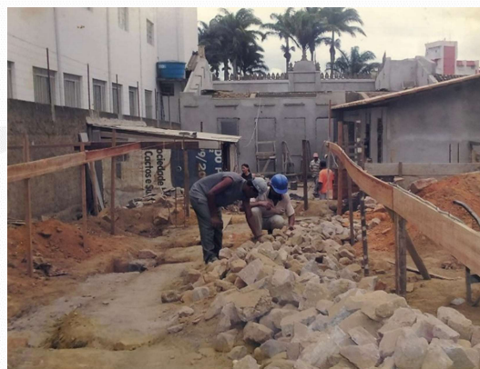
FIGURA 04: Processo Construtivo de Revitalização da Casa Regis Pacheco FONTE: APMVC
