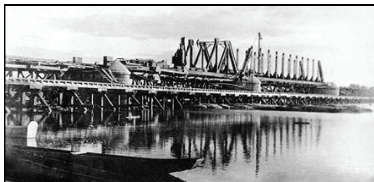
Figura 02: Construção da Ponte Marechal Hermes. Fonte: Revista do Instituto Histórico e Geográfico de Montes Claros, 2013.
