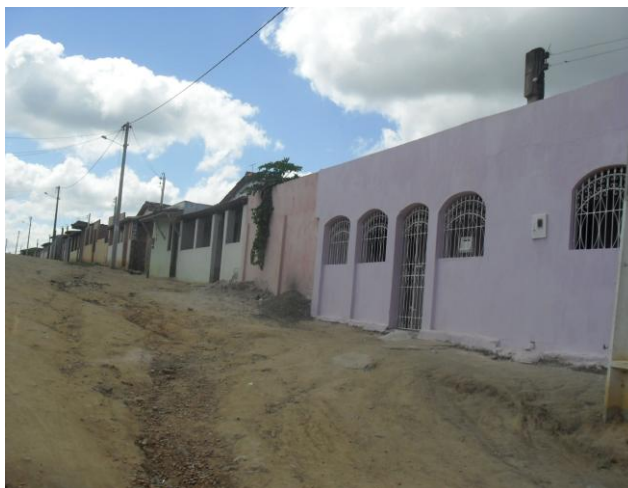
Foto 02 - Ruas sem pavimentação em Vila de Fátima, Serrinha/Ba – 2010
